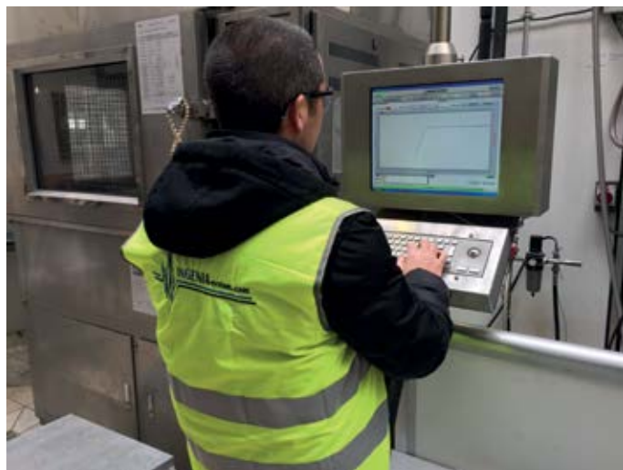
Un panel PC dialogue en USB avec le châssis qui effectue l'acquisition des mesures de pression et de débit pour la détection de fuites sur les radiateurs.
